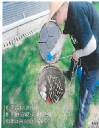
污水总排口 W1
