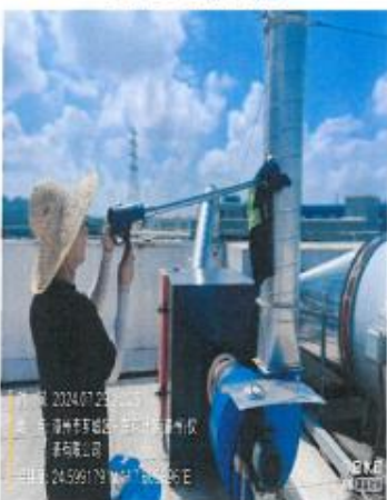
注塑废气排气筒出口 G8
