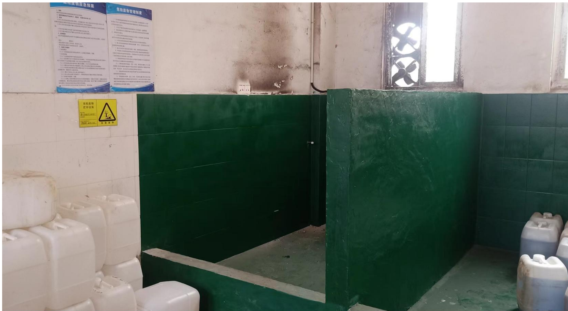
图 4-3 危险废物暂存间
