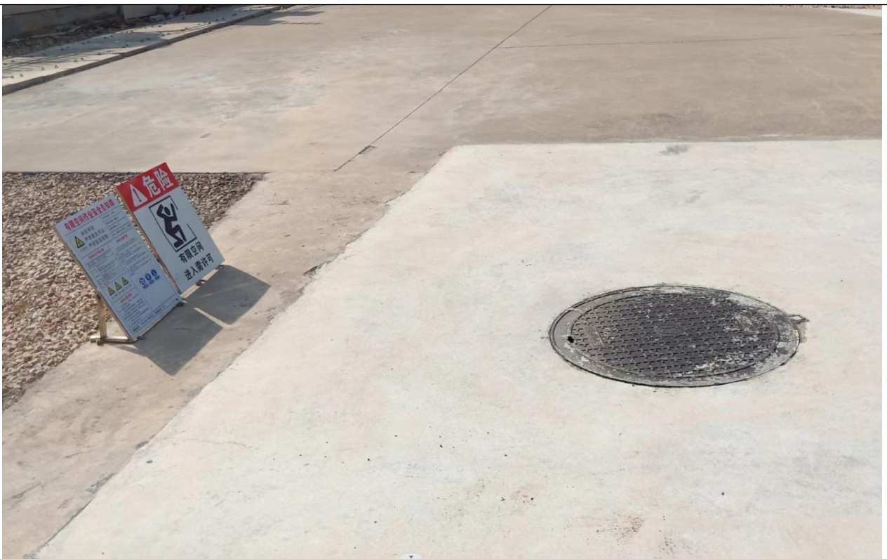
新建事故油池（10m 3 ）
