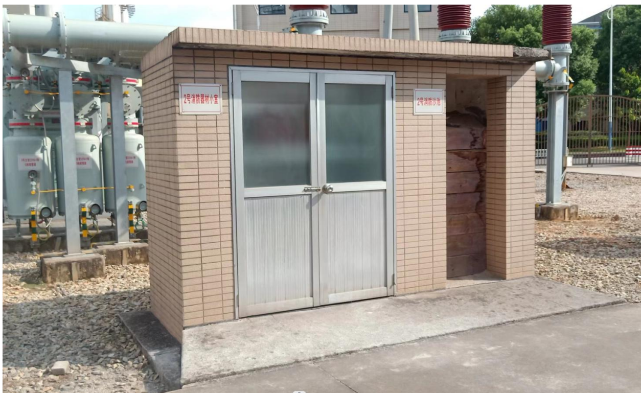
扩建前消防器材及消防沙池
