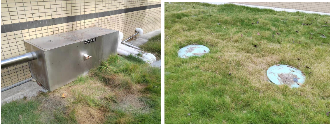
图 3-1 隔油池+化粪池
