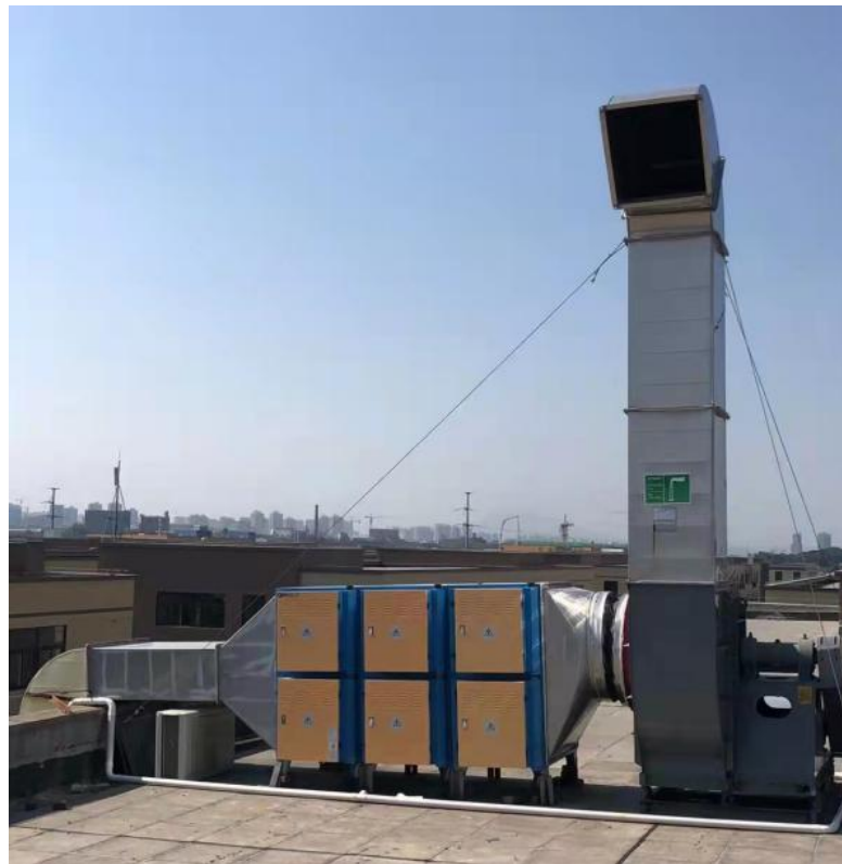
图 3-2 项目油烟净化器及排气筒
