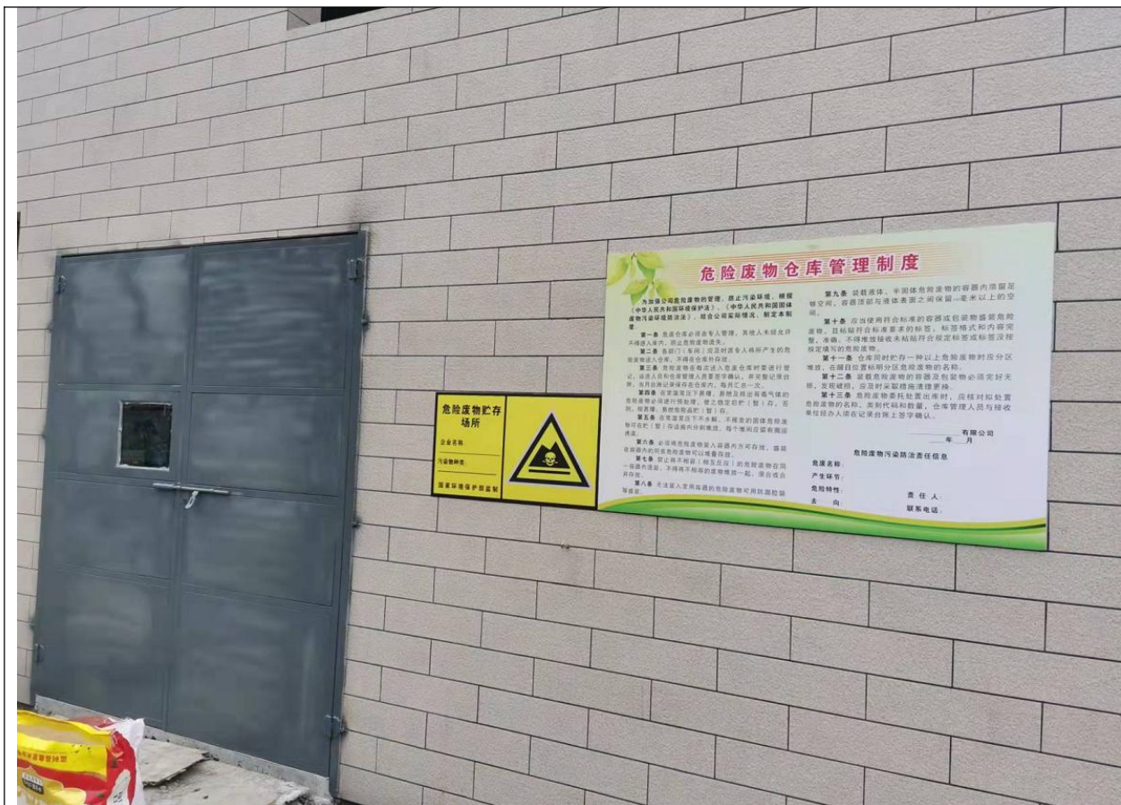
图 3-2 危险废物暂存间
