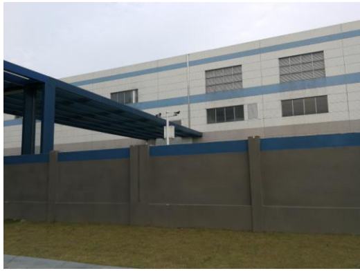
东侧现场 漳州顶津食品有限公司
