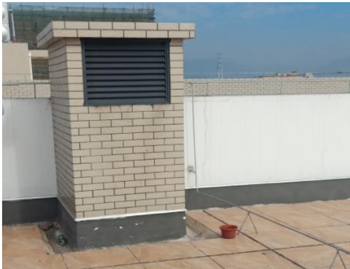
食堂油烟 图 3-3 废气处理设施图片
