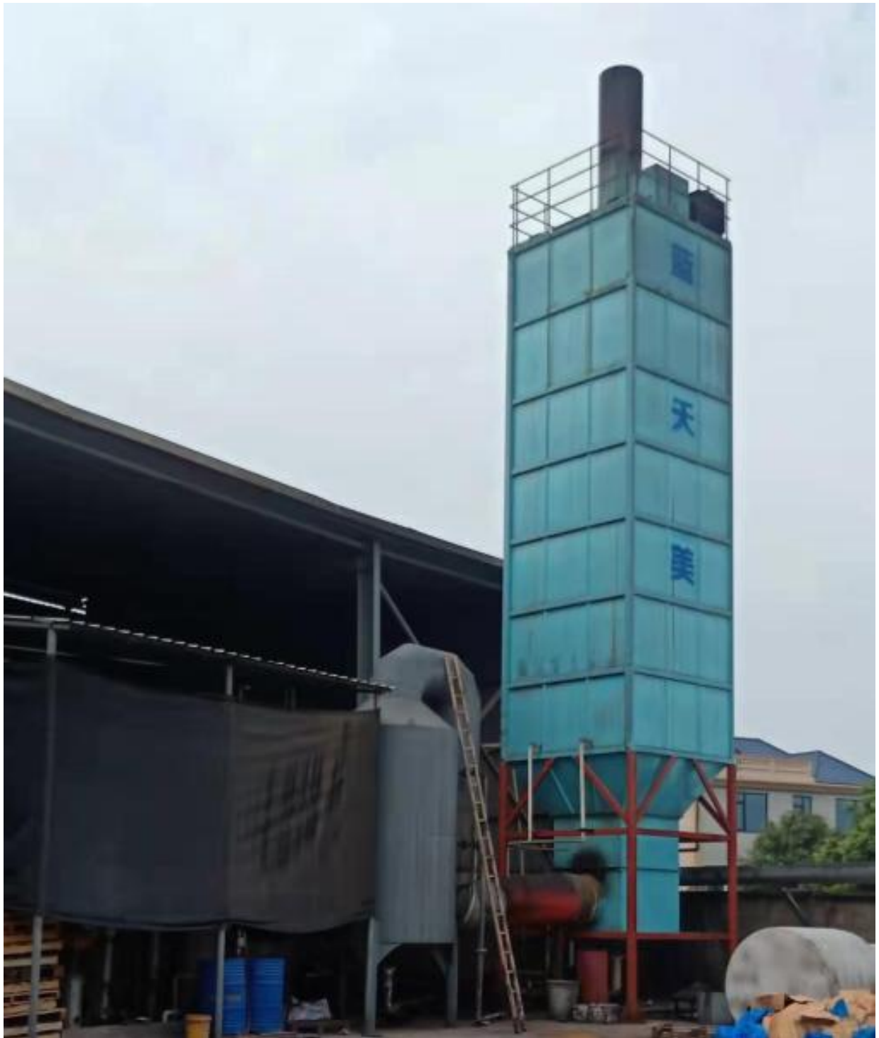
锅炉废气处理设施 (多管除尘+水浴+静电除尘+15m 高烟囱排放)
