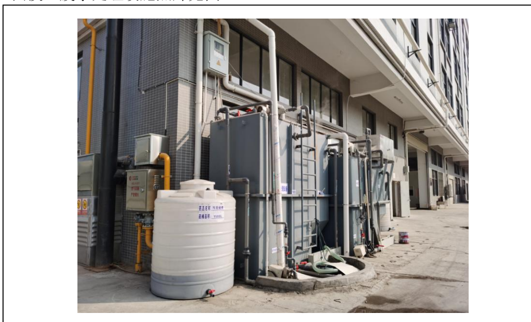
图 3-1 废水处理设施照片
