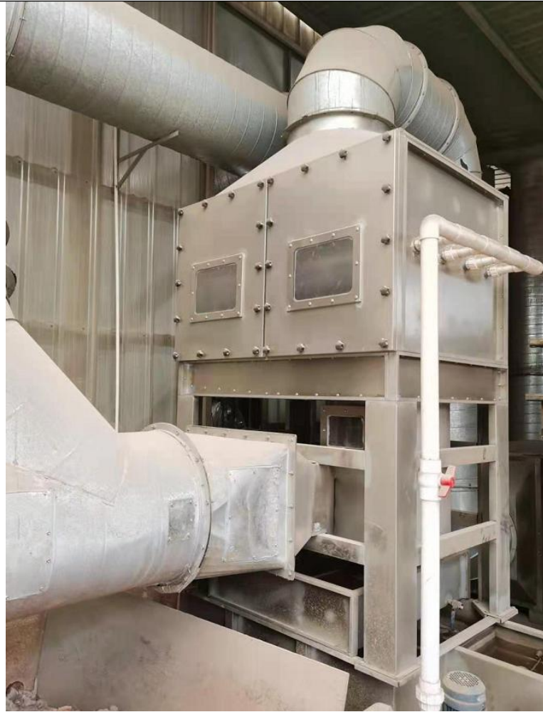
图 3-2 水喷淋+UV 光催化+活性炭吸附装置
