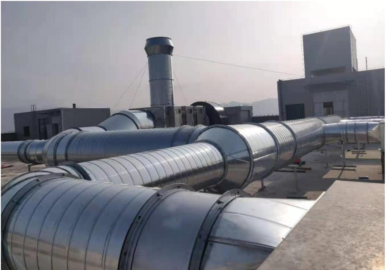
UV 光解净化装置+25m 高排气筒
