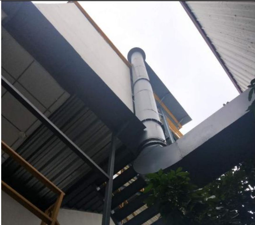
图 3-3 项目废气排气筒
