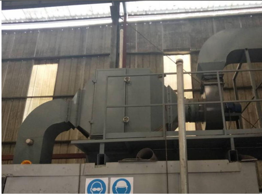
图 3-1 有机废气-过滤棉+活性炭吸附装置
