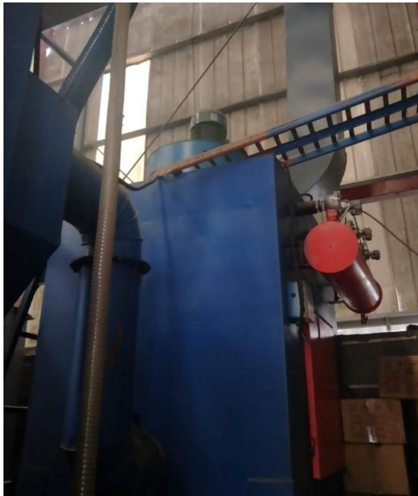
图 3-2 抛丸废气-袋式除尘器
