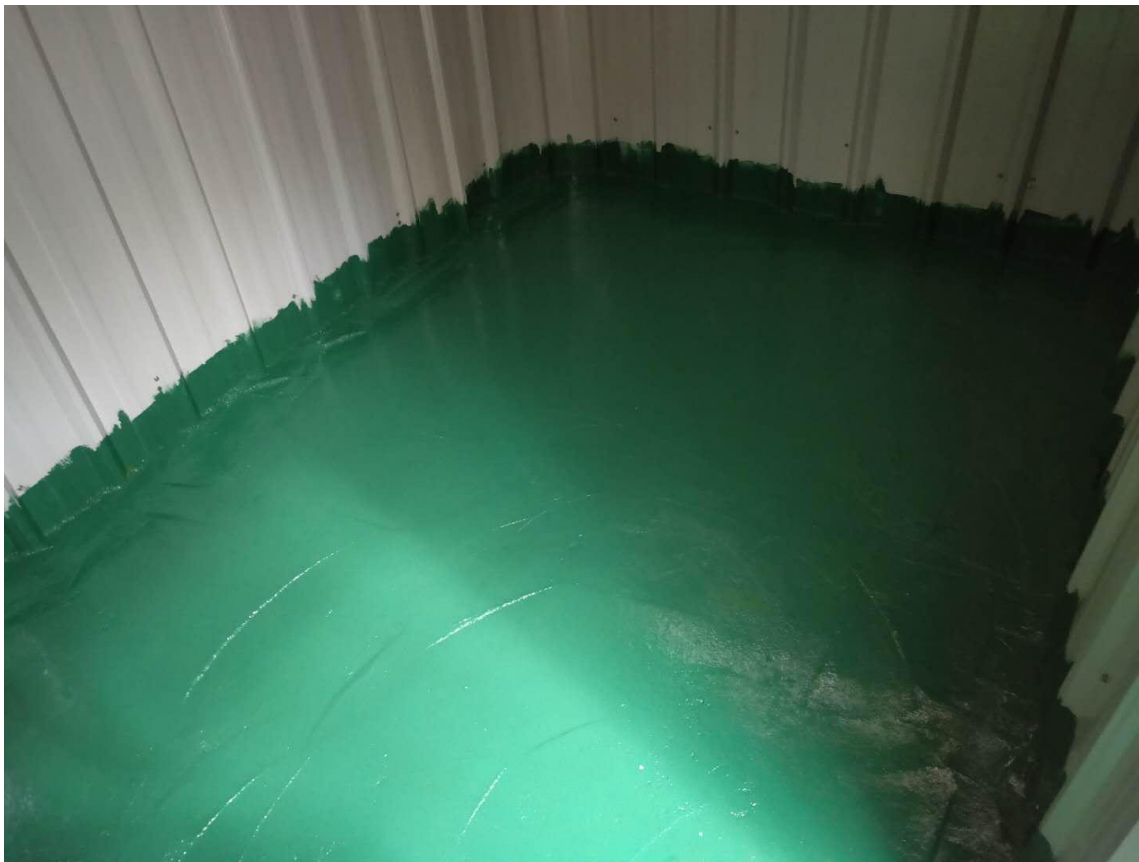
固体废物暂存间
