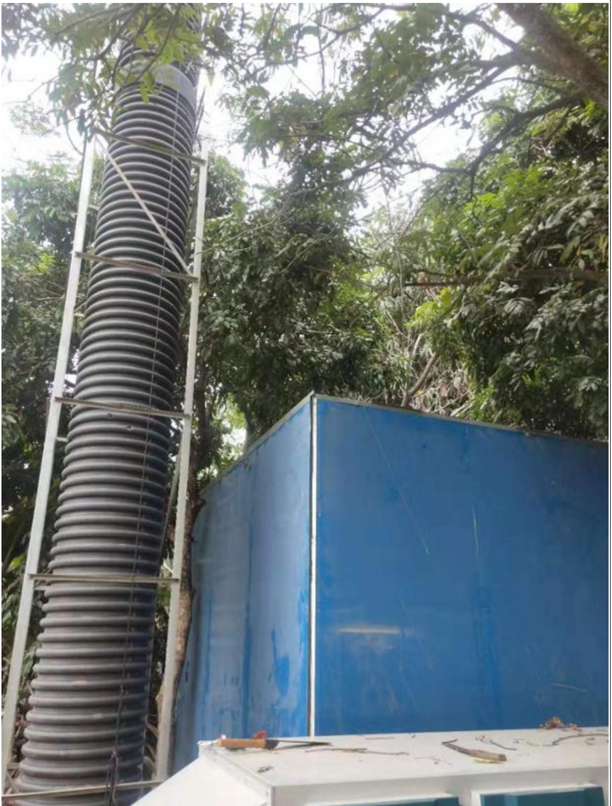
活性炭吸附+UV 光解净化+15m 高排气筒
