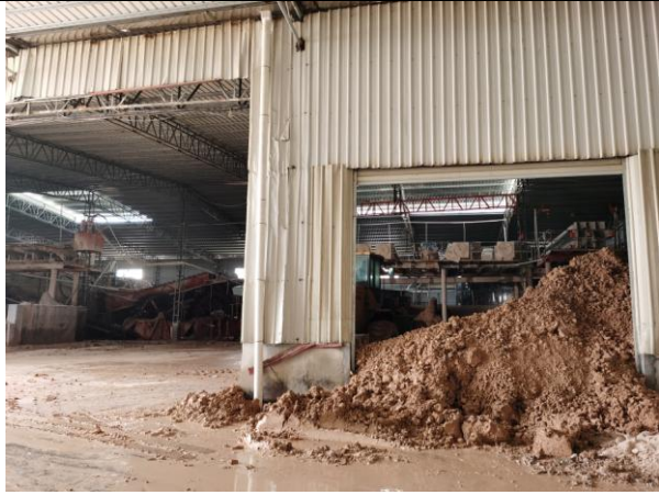
西侧现状 德兴工贸厂房
