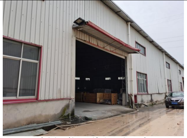
南侧现状图 德兴工贸厂房
