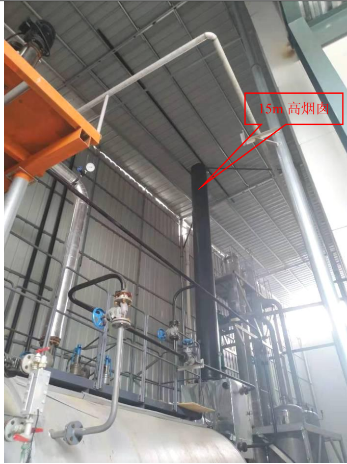
图 3-1 燃气锅炉烟囱
