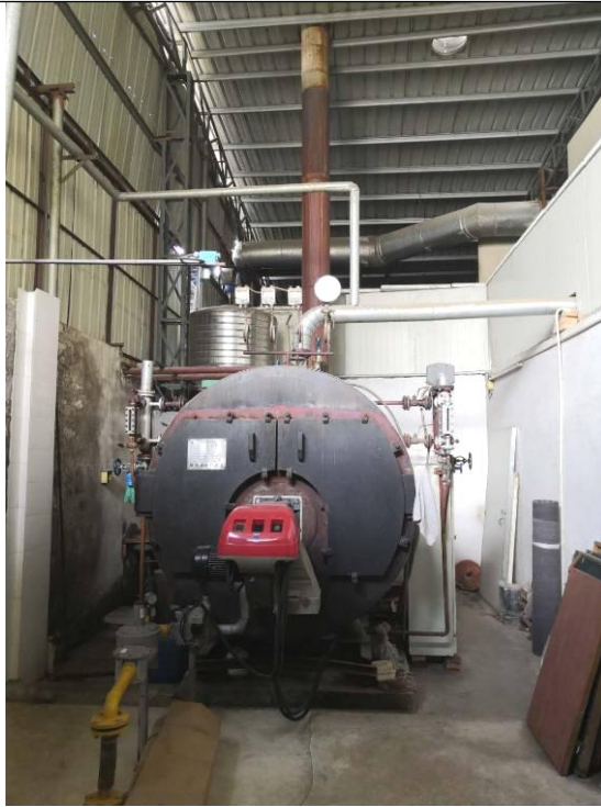
图 3-1 燃气锅炉烟囱
